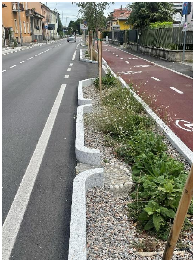
Lungo la strada
